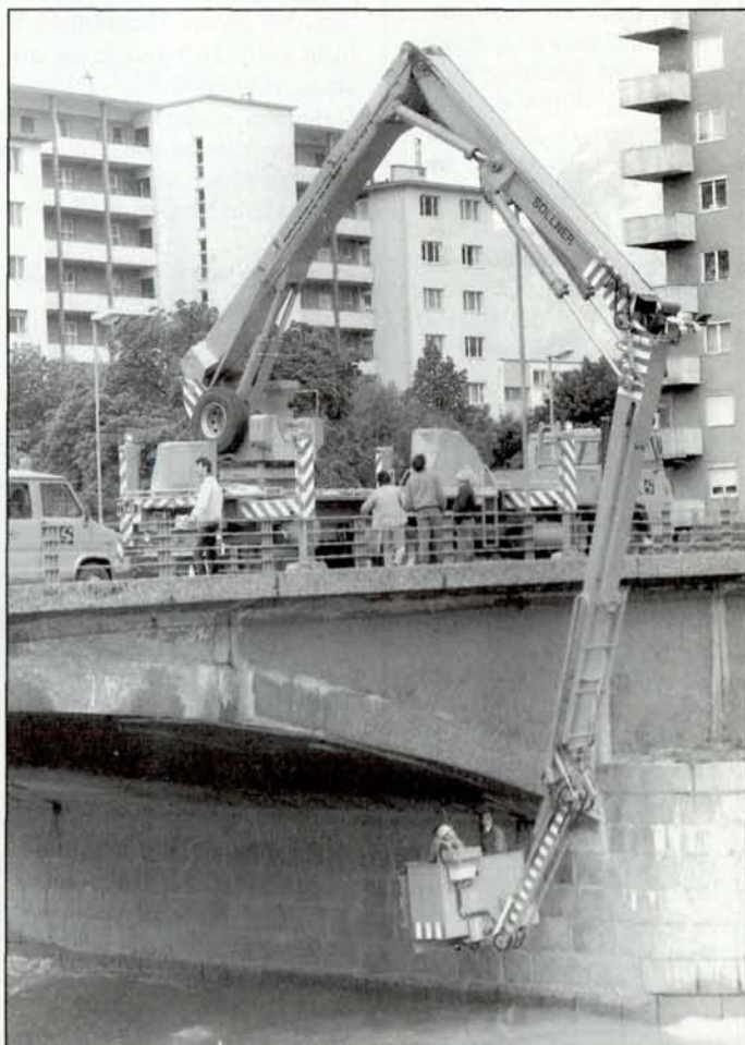
Mit Hilfe des Brückenrevisionswagens wird die Unterseite der Universitätsbrücke in Augenschein genommen. (Foto: Muraier)
