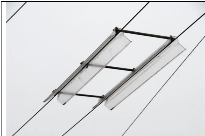
Virroittimien kiinnityskartiot
