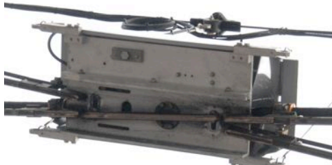
Trolli-trolli sähköinen risteämä alta
