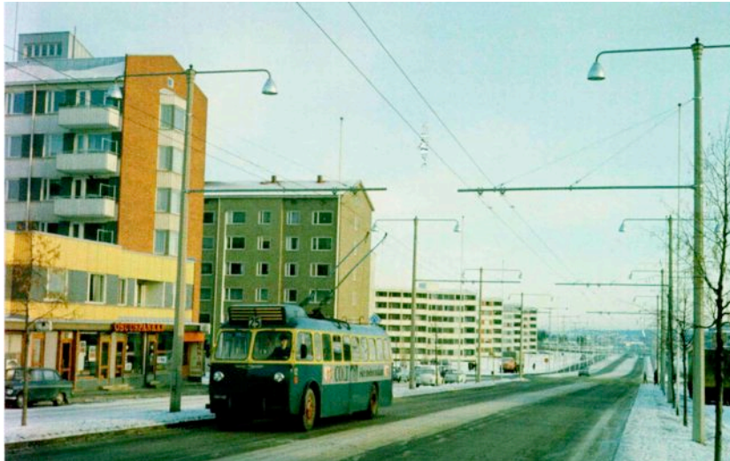
Kuva 3.4-2. Tampereen johdinautojen ajojohtojärjestelmän joustava ripustus Sammonkadulla. (Kuva: Mikko Alameri)
