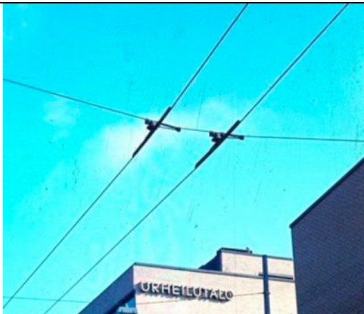
Kuva 3.4-3 Jäykkä ajolangan ripustuspiste Helsingin Topeliuksen kadulla (Kuva: Taimo Tuomi / SRS arkisto)
