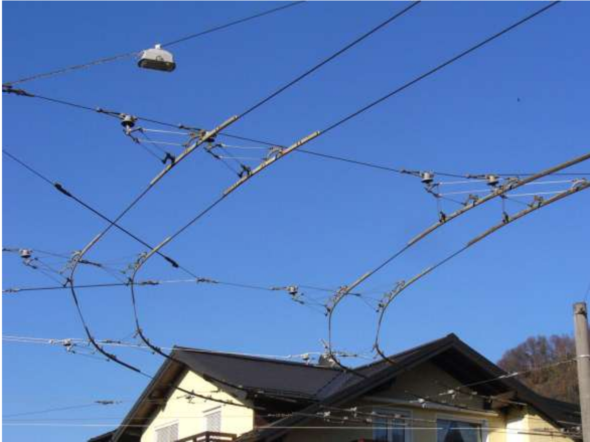
Kuva 17. Johdinautolinjaston tiukka kaarre. (Kuva Raimo Mättö).
