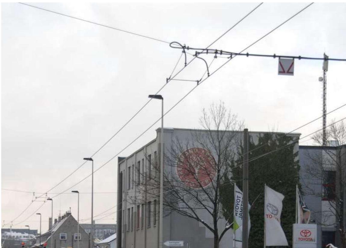
Kuva 10. Joustavasti ripustettu johdinauton ajolanka Solingenissa. (Kuva Artturi Lähdetie).
