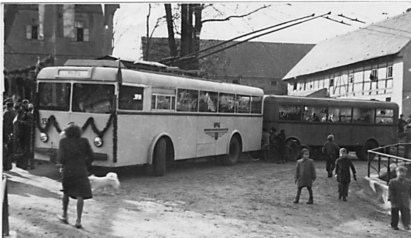
Die ersten Obusse waren von Henschel / Schumann Werdau. Schalttechnik: Ansaldo Italien (druckluftbetätigt! Obusse 151-161), Siemens (Obusse 162+163), später alle LEW Hennigsdorf (Beide Bilder aus dem Ortsarchiv Weißig)
