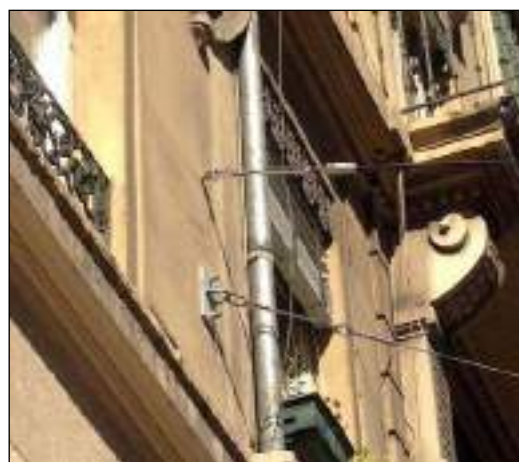
Figure 6-35 : Exemple de plaque de répartition à 2 ancrages, avant mise en peinture
