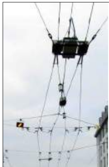
Figure 6-34 : Exemple d'illustration d'un aiguillage électrique
