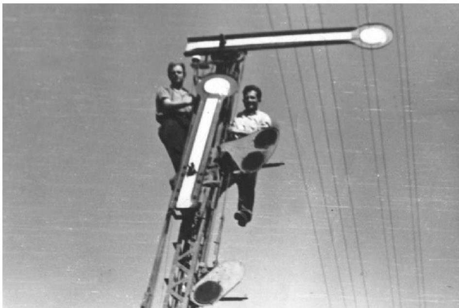
Electromecanici efectuând revizia unui semnal de intrare cu bra e în 1966
