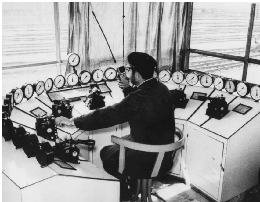
Postul de comandă al unui triaj prevăzut cu frân de cale cu aer comprimat în anii '70
