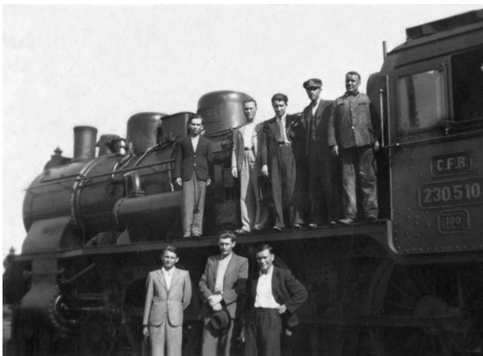
Locomotiva 230.510 echipat cu distribuție cu supape Lenz, în Depoul Arad în anul 1949
