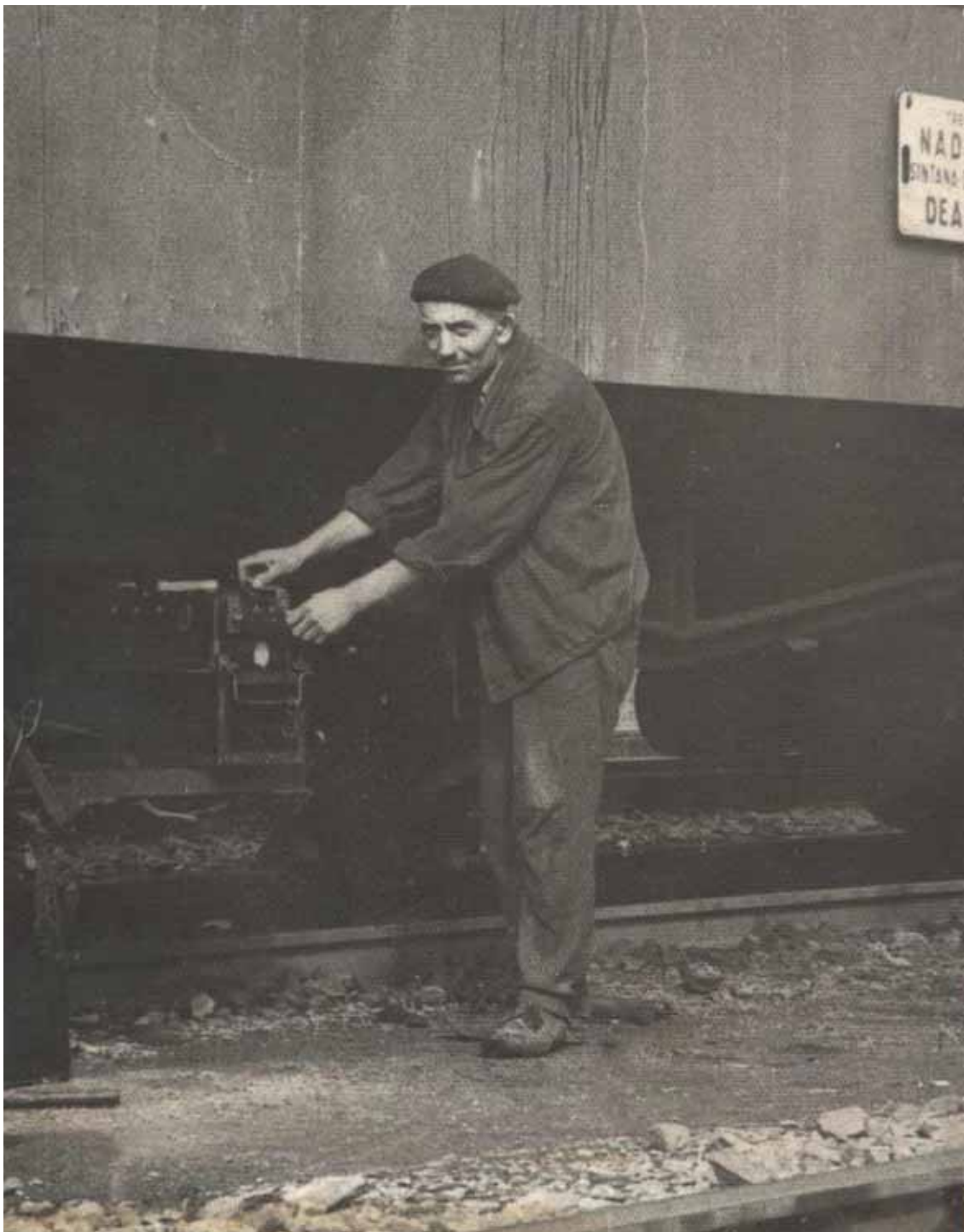
Electrician schimbând acumulatorii unui vagon
