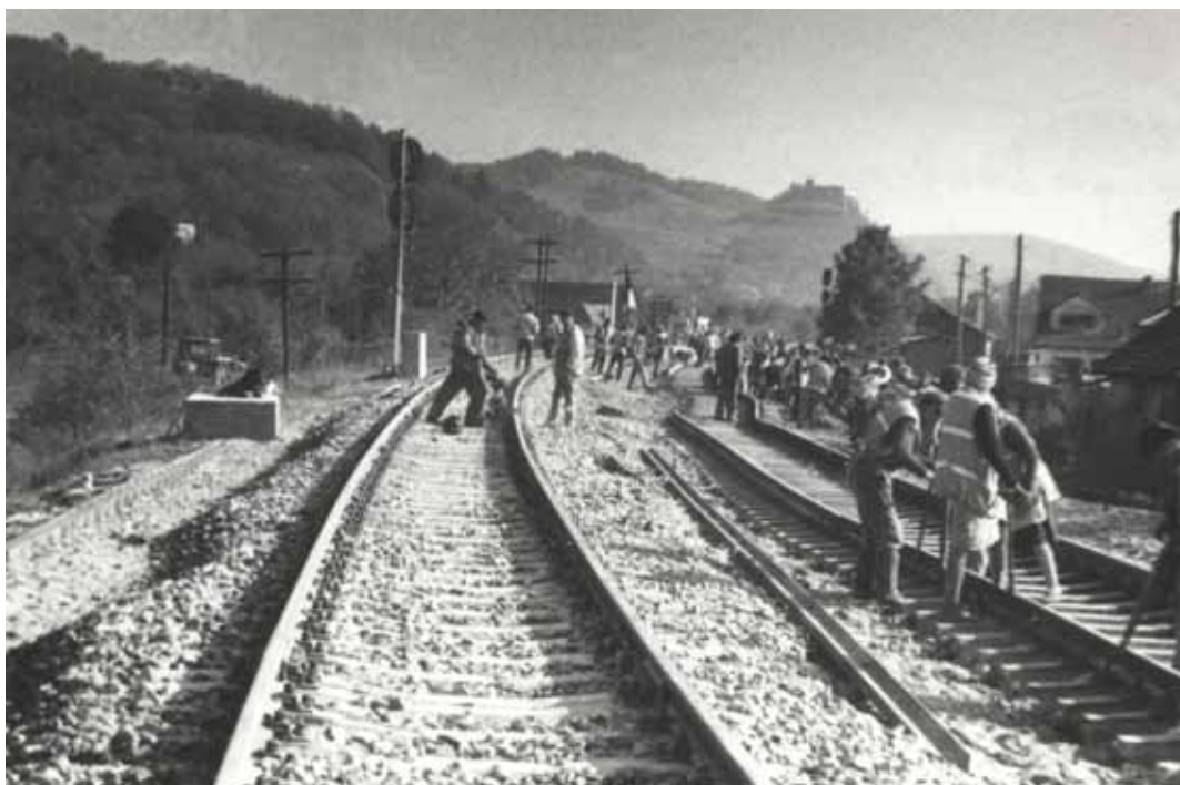
Realizarea inflexiunii la km 594+1/9 Milova – Radna. Linia II se ripează pentru a fi adusă în axă.
