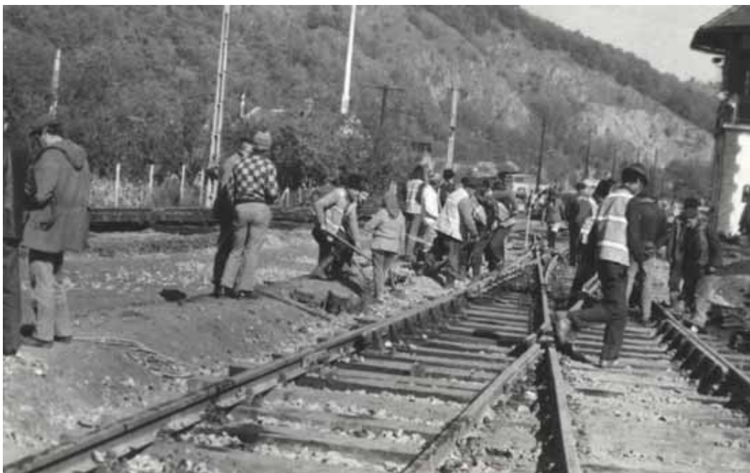
Introducerea bretelei combinate cap X în stația Radna în toamna anului 1984
