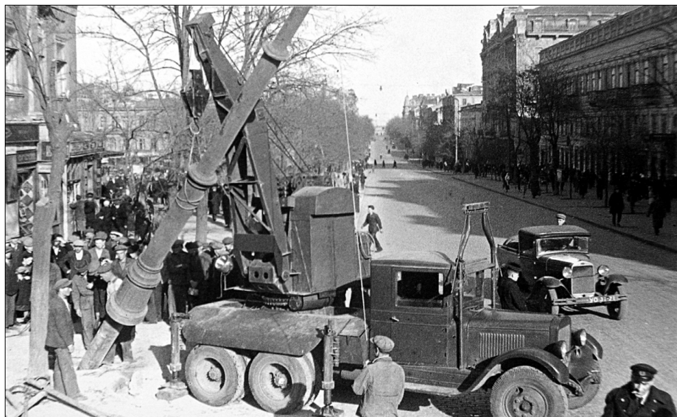
Fig. 1. Montarea stâlpilor pentru linia de troleibuz în Odessa, martie – aprilie 1941.
