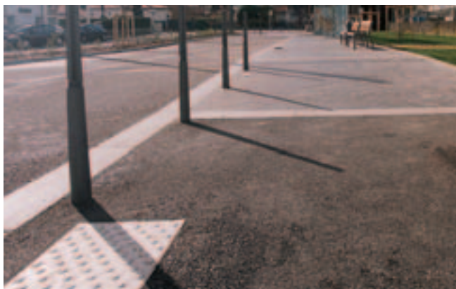
Dalle podotactile et quai surélevé
