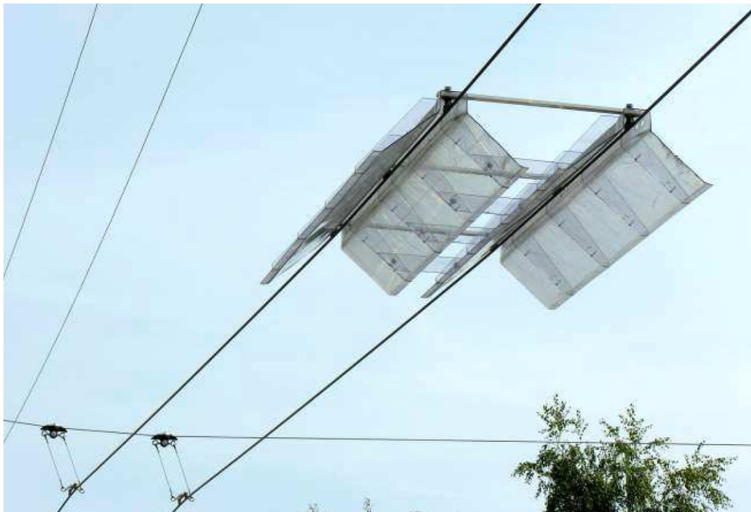
Kuva 16. Ohjaussuppilo ajolangoissa (kuva R. Mättö)
