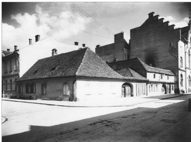
Foto 72. Case de la intersecția cu strada Xenopol (fostă Brukenthalgasse - str. Brukenthal), care vor fi demolate pentru a ridica o nouă clădire. Fotografie înainte de 1930.
