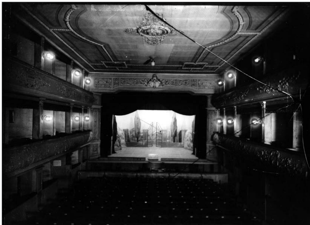
Foto 26. Interiorul teatrului după reconstruirea sa din 1827, având ca model arhitectural teatrul vienez „Leopoldstädtertheater”. Fotografie din anii '30.
