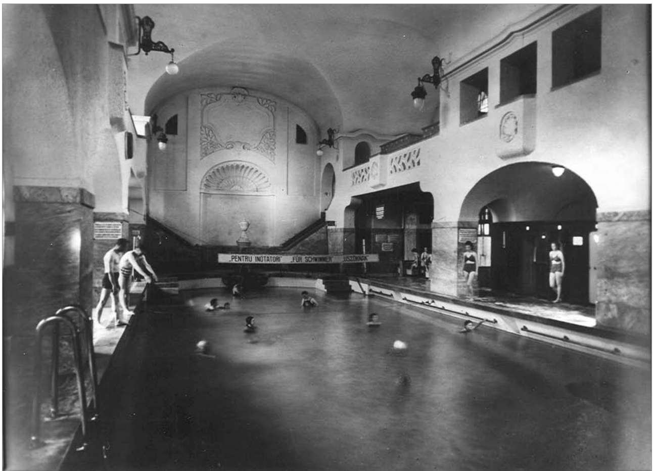
Foto 93. Interiorul băii. Fotografie din anii '30.
