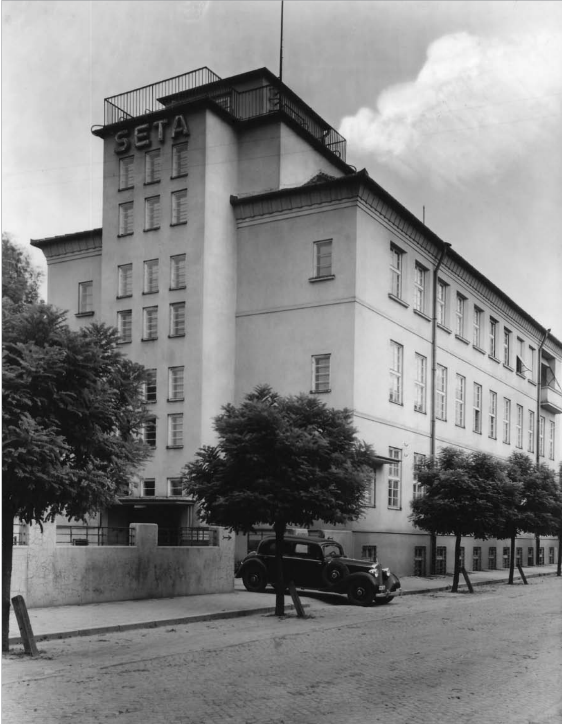
Foto 3. Clădirea „SETA”–Societatea Electrică Transilvăneană (fondată în 1924), care avea ca obiect de activitate producerea, transportul și distribuirea energiei electrice în județele Sibiu, Târnava-Mare, Târnava-Mică, Alba, Mureș, Odorhei, Făgăraș și Hunedoara. Fotografie din anii '30.
