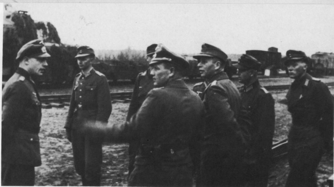
Inspektion bei Panzerzügen südlich von Polozk Ende April 1944. 2. v. r.: Oblt. (später Hauptmann) Hoppe, Kommandant des Panzerzuges Nr. 67; 3. v. r.: Oberstlt. von Türckheim, später Kommandeur der Panzerzüge bei der HGr. A (Panzerzug-Regiments-Stab Nr. 2); 5. v. r.: (im Profil mit Schirmmütze und Pistolentasche) Hptm. Fischer, Kommandant des Panzerzuges Nr. 26; ganz links: Lt. Sitzius, Kommandant des Befehlszuges Nr. 72A. Im Hintergrund der Panzerzug Nr. 26. (SA)
