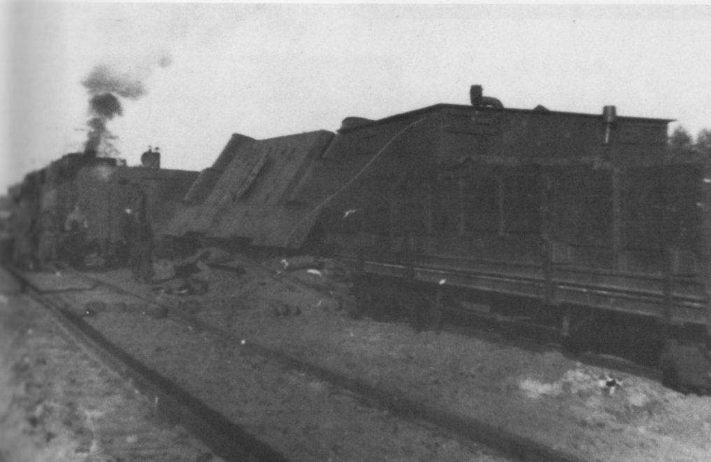
Oben: Die Geschützwagen des Panzerzuges Nr. 21. Links der stromlinienförmige Wagen aus den zwanziger Jahren. Vorn die 7,5-cm-F.K. 02/26(p), hinten die 10-cm-le.F.H. 14/19(p). Rechts der eintürmige und zweitürmige Wagen älterer Bauart (1918/19). Solche Wagen besaß auch der ebenfalls aus polnischem Beutematerial bestehende Panzerzug Nr. 22 (siehe Heft I, S. 7 und 8). (SA)
