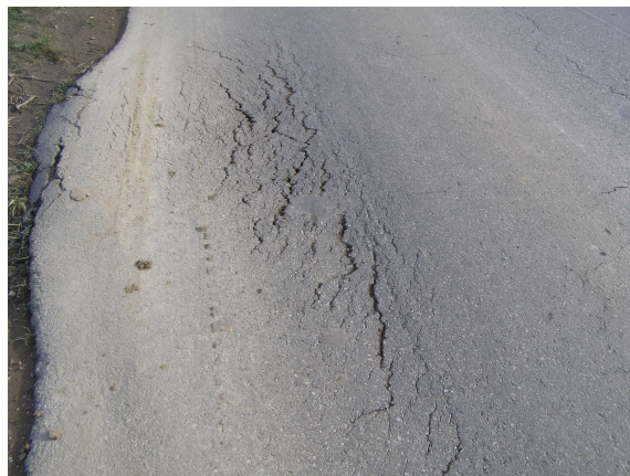
2. DJ 592. Refulare de margine. Fisuri
