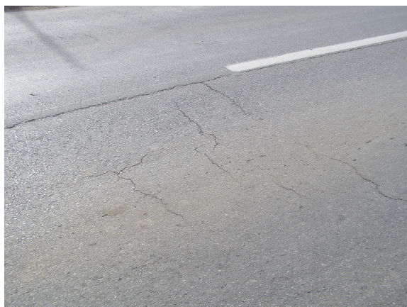
3. DJ 592. Fisuri transversale
