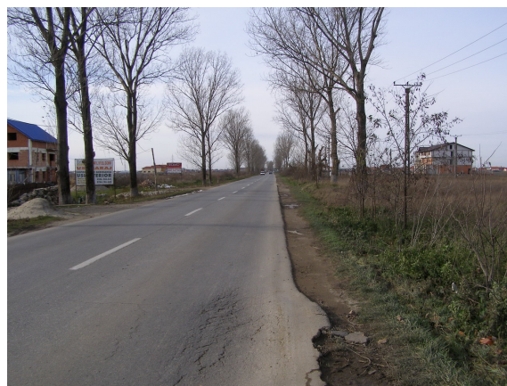
4. DJ 592. Fagase si refulari de margine
